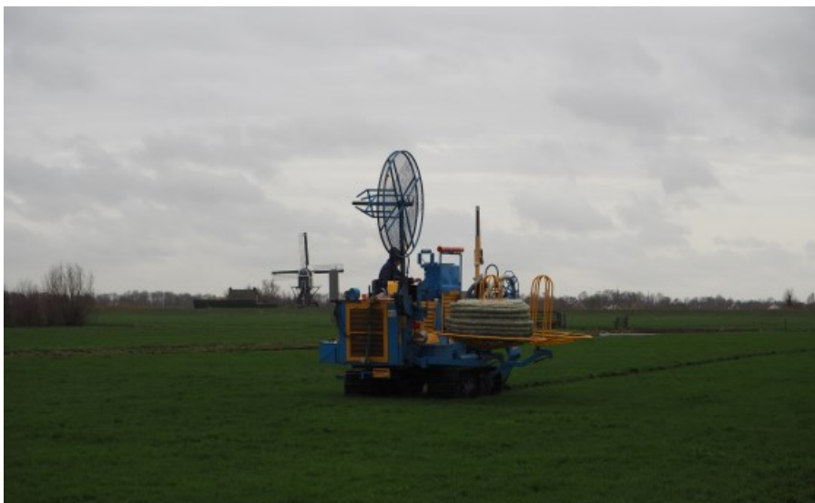
Aanleg onderwaterdrainage Foto LTO Noord
